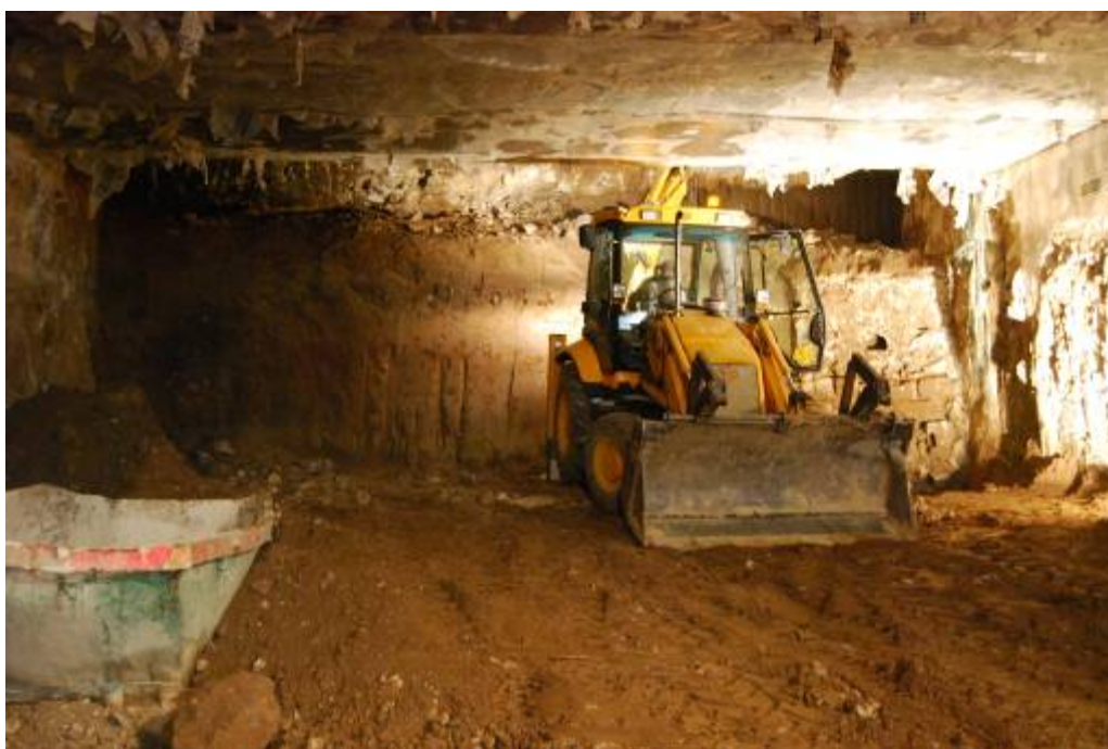
Fotografia núm. 10: eliminació de l'estratigrafia moderna mitjançant retro-excavadora
