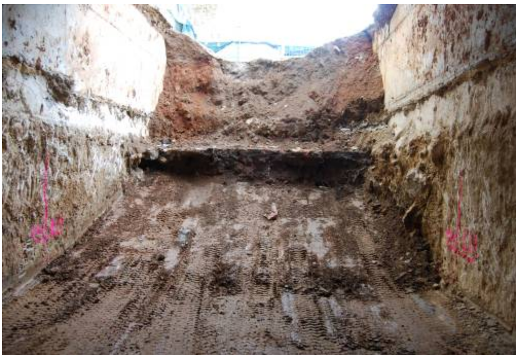
Fotografia núm. 17: finalització del rebaix de l'estratigrafia moderna a la plataforma
