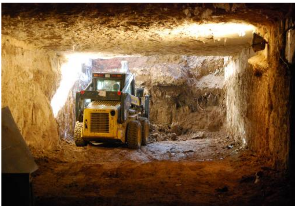
Fotografia núm. 16: arribada al pou de l'escala d'accés a la futura estació
