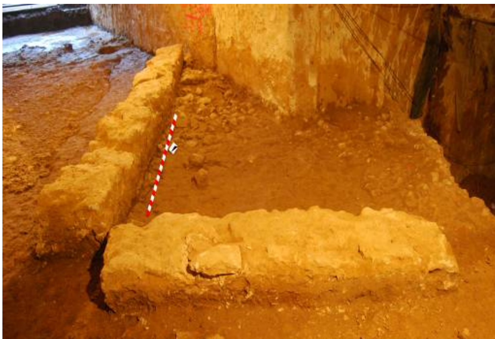
Fotografia núm. 29: enderroc de la segona fase constructiva a l'interior de l'àmbit
