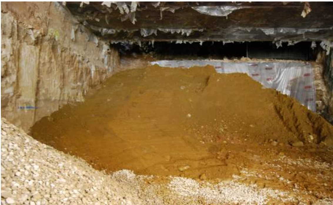
Fotografia núm. 12: rampa d'accés a la plataforma
