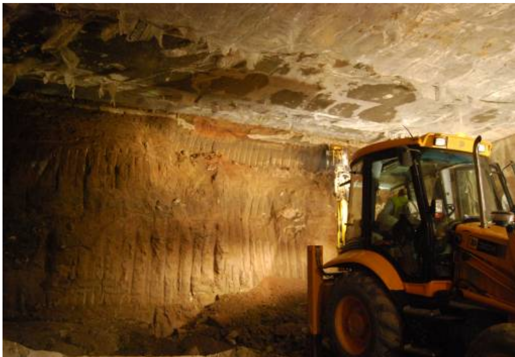
Fotografia núm. 9: eliminació de l'estratigrafia moderna mitjançant retro-excavadora
